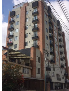
7-6: Inmueble de 10 pisos con 43 apartamentos, 2 locales comerciales, sala comunal, parqueaderos, Sylca constructores, Ciudad Berna. Fotografía tomada en 2018 por M. Charbonnier
